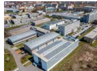
Fraunhofer IWU, Chemnitz, Dresden, Zittau
